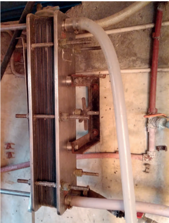
Imagen 2. Intercambiador de calor de placas
