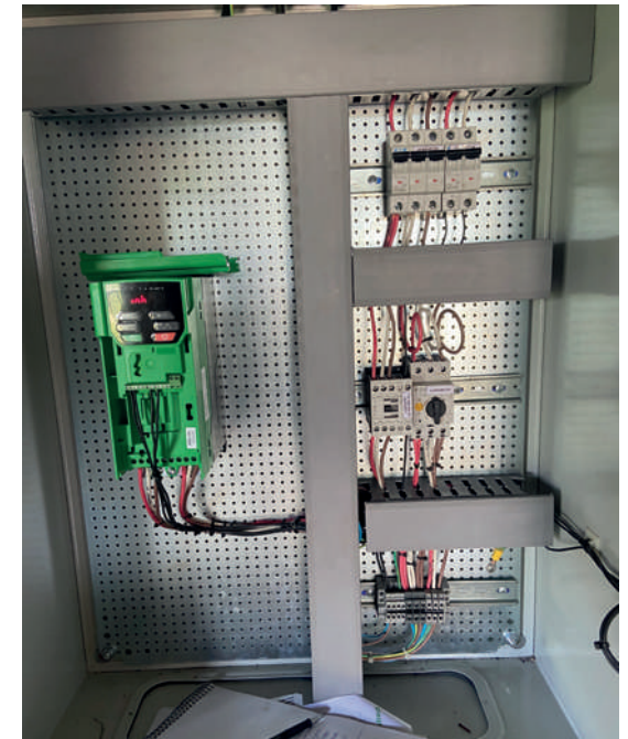
Imagen 1. Variador de velocidad o de frecuencia
